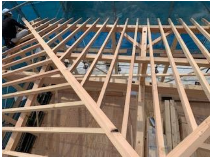
棟上げ 建前工事
